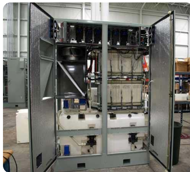
50kWh ZBB EnerStore
